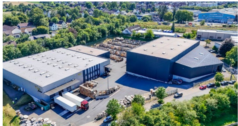
Fotos: Böhm Kabeltechnik
